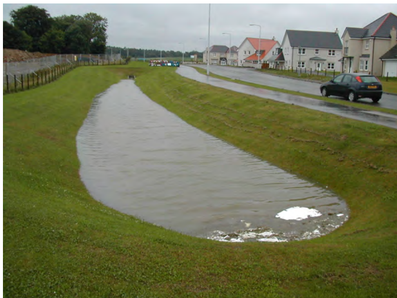
Figura 7 - Bacino di detenzione
