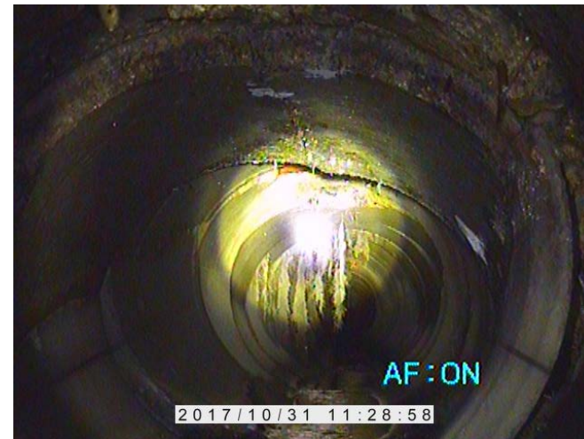
Piccoli cedimenti del terreno (cancello non perpendicolare a pilastro) e sottostante schiacciamento della tubazione che lo causa.
