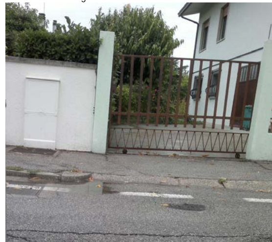
Piccoli cedimenti del terreno (cancello non perpendicolare a pilastro) e sottostante schiacciamento della tubazione che lo causa.
