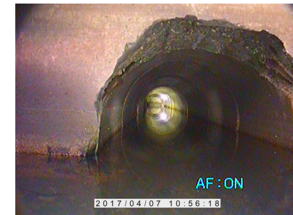
Attraversamento di via Circonvallazione
