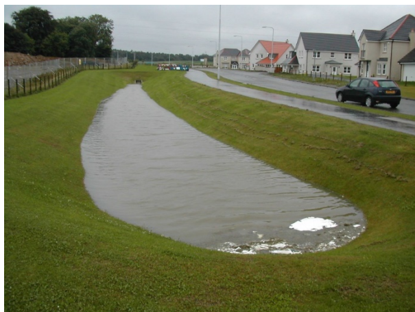
Figura 5. Bacino di detenzione
