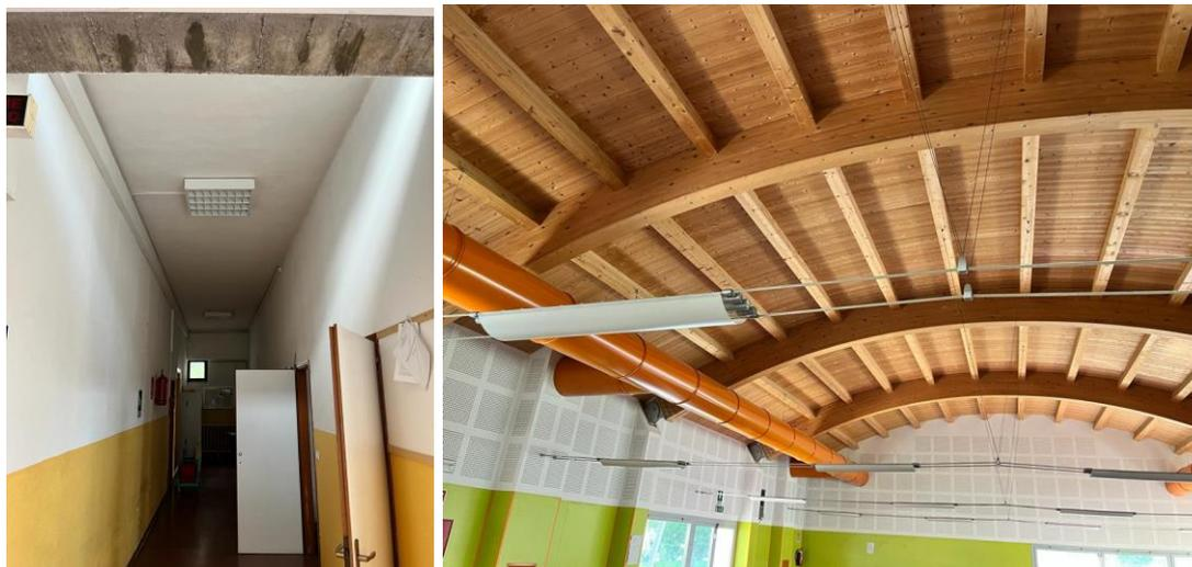
Se ne prevede la sostituzione con altre a LED ad elevata efficienza. La sostituzione sarà fatta utilizzando i medesimi punti luce esistenti. È prevista una ridipintura della zona circoscritta per eliminare eventuali segni lasciati dal vecchio corpo illuminante.
