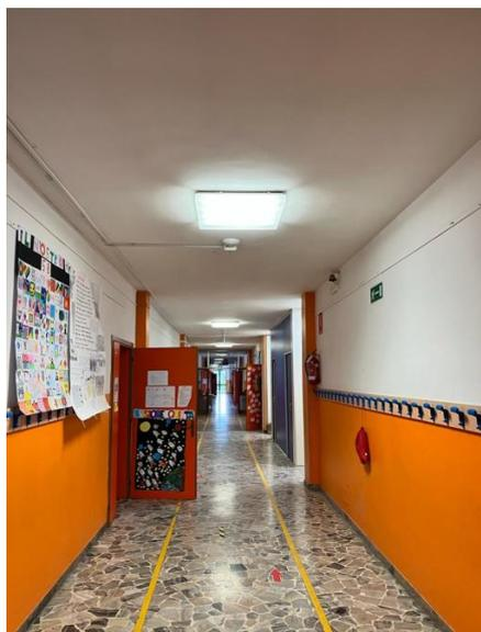
Sono previste lampade a plafone ON-OFF a LED di vari diametri. Si sfrutteranno i punti luce esistenti. Le lampade sono di diversa tipologia in funziona della geometria del locale come da progetto allegato.
