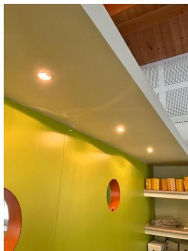
Sono previste lampade ARKEON con scheda di controllo DALI per la gestione intelligente, con comando manuale tramite i comandi luce esistenti o eventuali pulsanti o da integrare. Sono previsti dei sistemi fila continua LED come da progetti allegati. Il corpo illuminante è stato scelto per permetterne un montaggio rapido e veloce con premontaggio a terra. Verranno installati inoltre tre faretto HALL ESSENTIAL per l'illuminazione dell'area d'accesso alla sala refezione.
