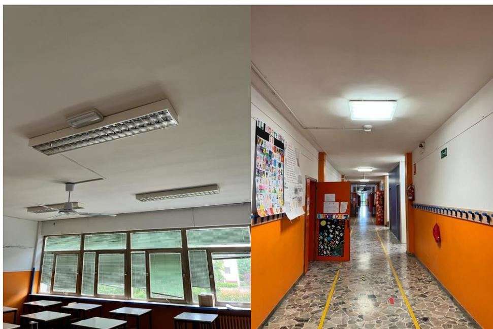
Se ne prevede la sostituzione con altre a LED ad elevata efficienza. La sostituzione sarà fatta utilizzando i medesimi punti luce esistenti. È prevista una ridipintura della zona circoscritta per eliminare eventuali segni lasciati dal vecchio corpo illuminante. Nella zona elementari la dipintura potrebbe assumere forme di fantasia quali nuvolette, nella parte medie, invece, manterrà una forma geometrica regolare.
