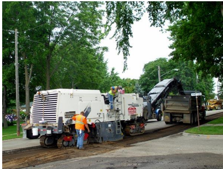
Fig. 6 Lavori di fresatura
