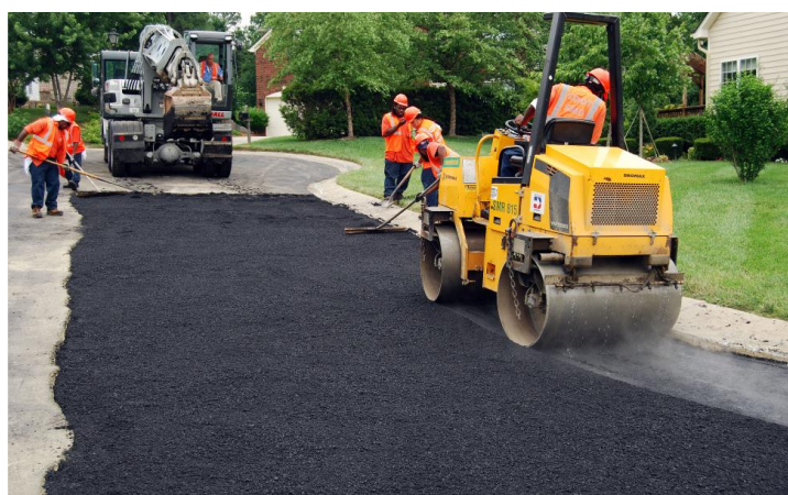
Fig. 8 Stesa manto bituminoso
