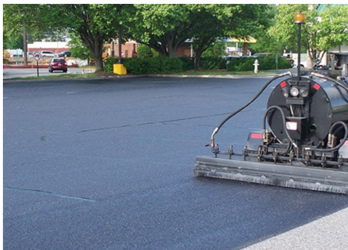
Fig. 7 Spruzzatura emulsione bituminosa
