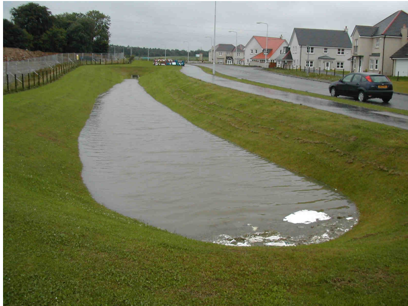
Figura 7 - Bacino di detenzione
