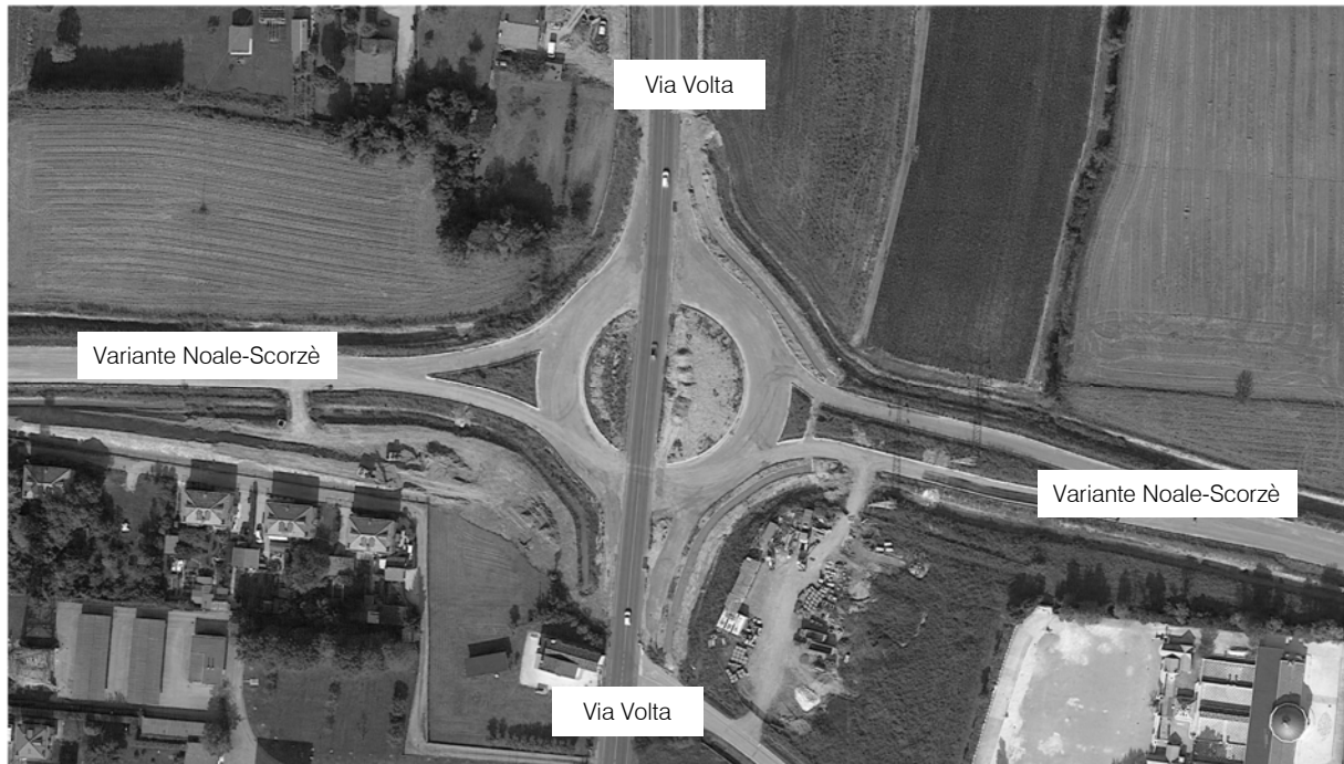
Figura 4.17 – Ortofoto nodo 3 (immagine con rotatoria in fase di realizzazione)
