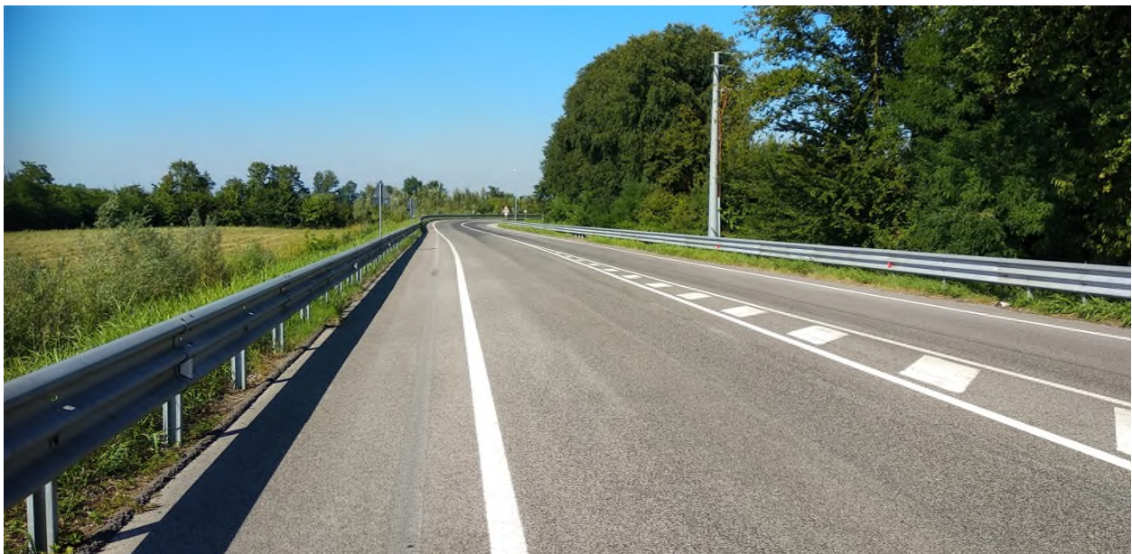
Figura 4.11 – Svincolo A4 "Casello di Martellago"
