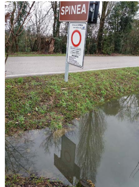
Fig. 2: Via Zigaraga tratto a est del Passante: ristagni d'acqua, attraversamento da pulire (intervento N. 202) e incile del fosso da espurgare lato sud (intervento N. 203).
