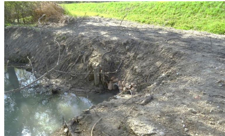
Punto 5 _ le paratoie in legno sostituite da due tubazioni da 30 cm sull'argine di separazione tra lago delle tartarughe e Rio Storto
