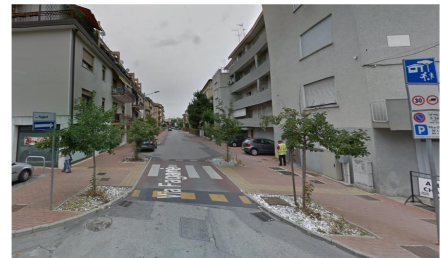
Figura 26: Varco di ingresso di una zona 30 rialzato con colorazione a Mestre [Fonte: Google Maps]
