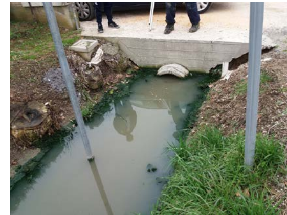
Via Cavino: ristagni d'acqua e sezione fossato insufficiente
