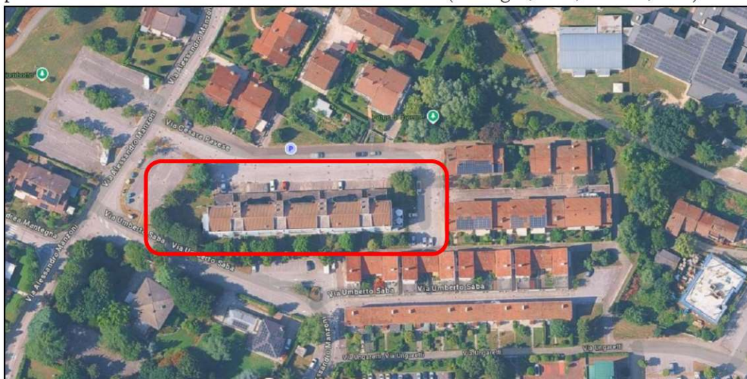
Individuazione dell'area di cantiere
