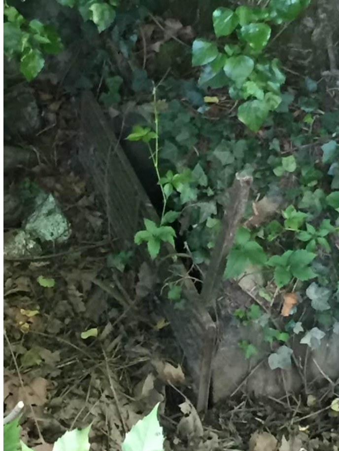
Foto 1: Ambito Est – imbocco tubazione DN 1000 mm in contropendenza.
