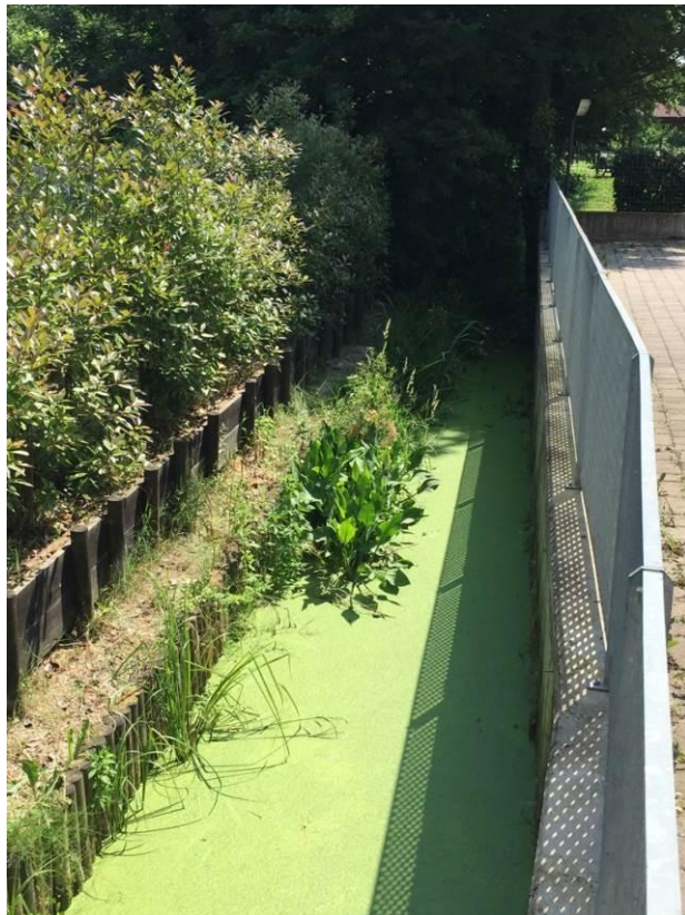
Foto 4 : Ambito Est - Fossato con sponde verticali in pali di castagno a valle del tombinamento.
