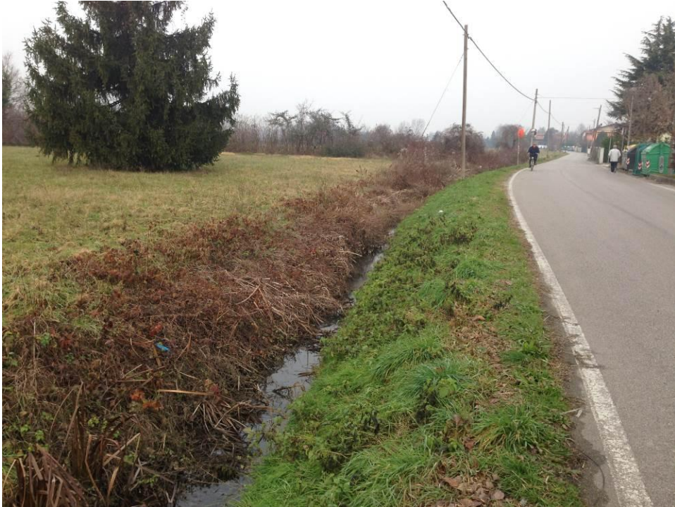
Foto 19 : Ambito Ovest – fossato di via Matteotti.
