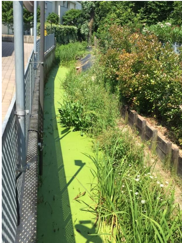
Foto 3 : Ambito Est - Fossato con sponde verticali in pali di castagno a valle del tombinamento.
