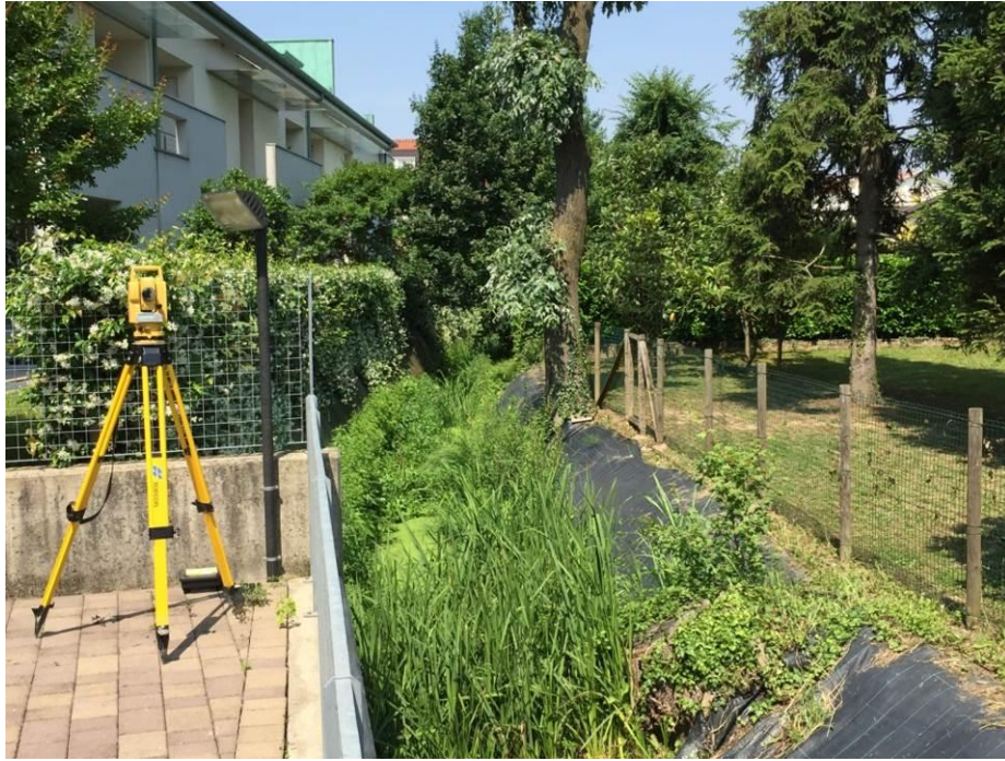
Foto 7 : Ambito Est - Fossato realizzato nel tratto finale verso via Olmo a valle del tombinamento.
