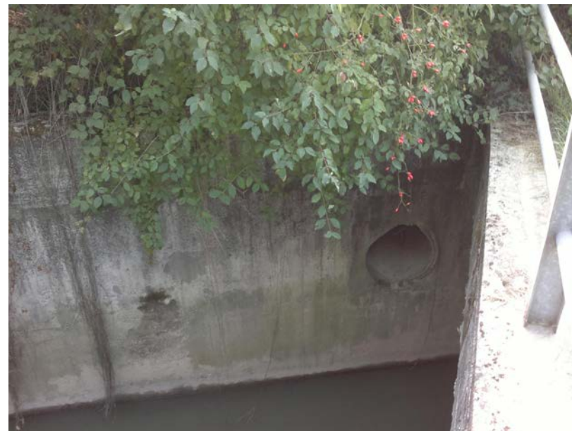
Pozzetto in via Cattaneo con acqua stagnante ed esempio di scarico in Roviego senza clapet
