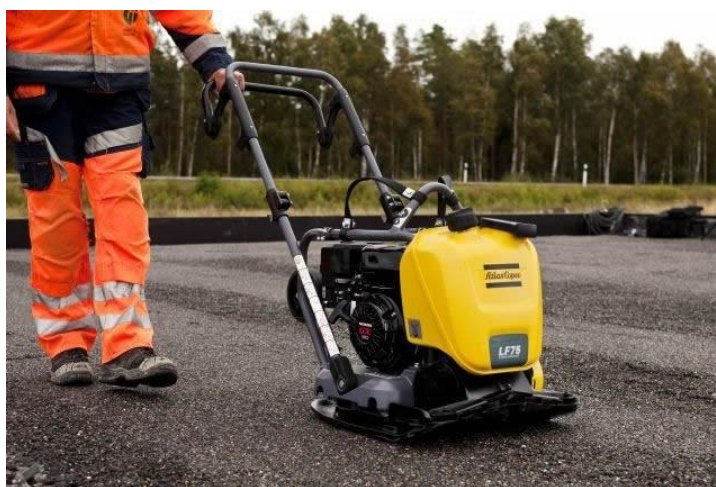
Fig. 9 Compattazione con piastra vibrante
