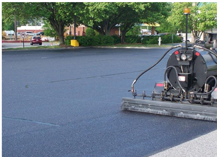
Fig. 7 Spruzzatura emulsione bituminosa
