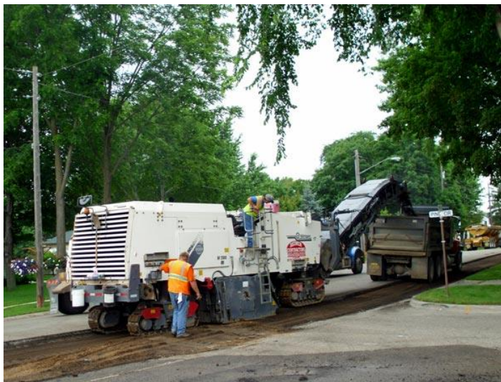
Fig. 6 Lavori di fresatura
