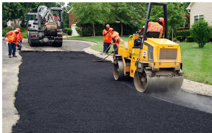
Fig. 8 Stesa manto bituminoso
