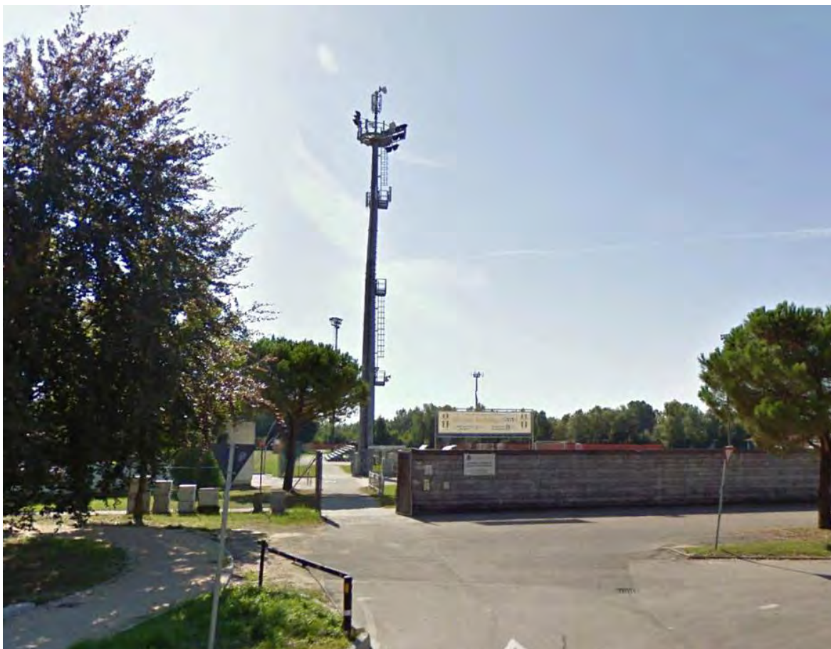
Figura 4-2: Antenne per telefonia mobile installate su palo dell'illuminazione presso gli impianti sportivi di Martellago
